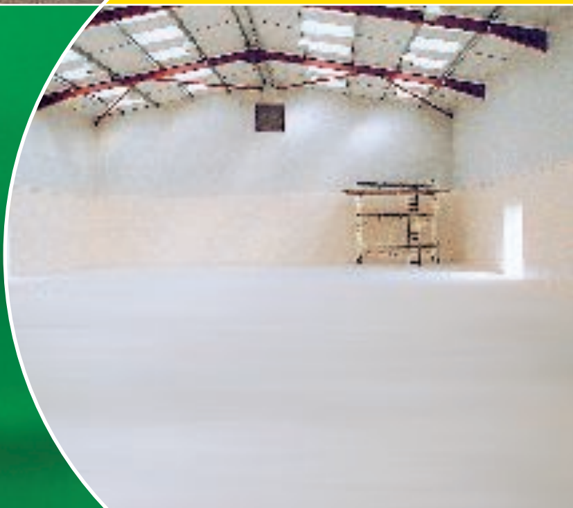
Rivestimento igienico a base d'acqua, Wall-Tech WB, applicato alle pareti interne in questa fabbrica di prodotti alimentari. Soddisfa le norme USDA e FDA per contatto con gli alimenti.
