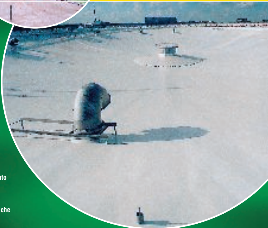
Tetto di un albergo protetto con Poly-Tech WG, rivestimento monocomponente liquido che si trasforma in membrana. Può essere applicato anche in inverno.
