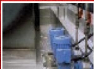
Un'area protetta rivestita con Chemi-Tech UC per contenere entro l'area ogni perdita d'olio.
