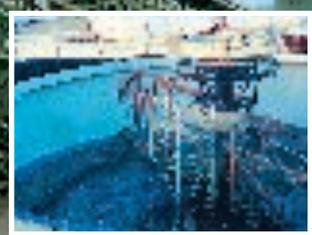
Struttura in acciaio molto corrosa ripristinata e protetta con Corro-Tech GP e Chemi-Tech CR.
