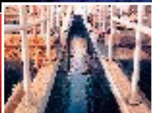
Rivestimento Chemi-Tech EP resistente agli acidi applicato ai canali di scarico di questo impianto trattamento acque.
