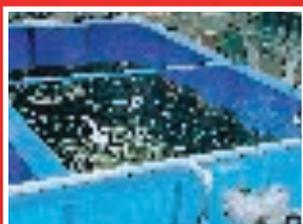
Chemi-Tech CR, un rivestimento senza solventi, usato per proteggere le superfici metalliche interne e esterne di un serbatoio di impasto refrattario semiliquido.
